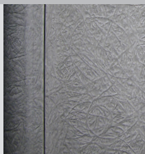
Columna lateral texturizada
