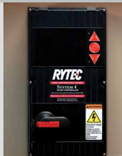
System 4 montré avec débranchement rotatif facultatif
