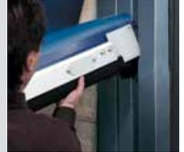
Las lengüetas Break-Away se reinsertan en las columnas laterales.
