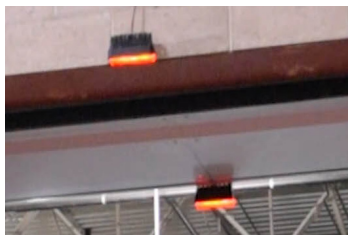
Faisceaux lumineux au-dessus de la porte des deux côtés
